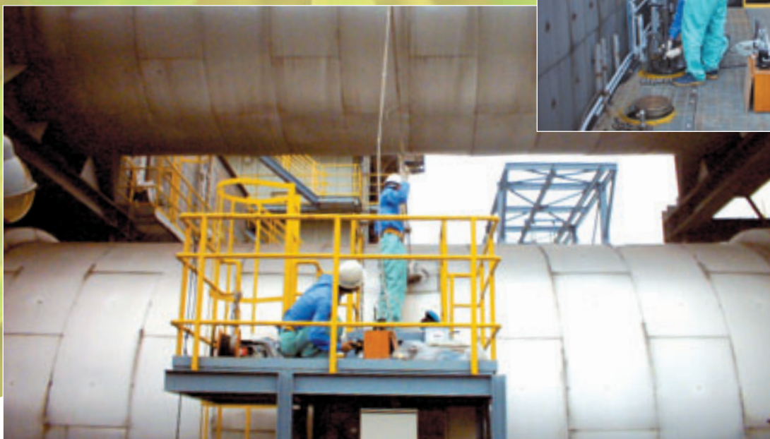
工場排ガス測定風景
